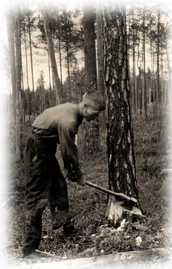
Злобин Петр Яковлевич. Выполнение подруба дерева перед его направленной валкой
