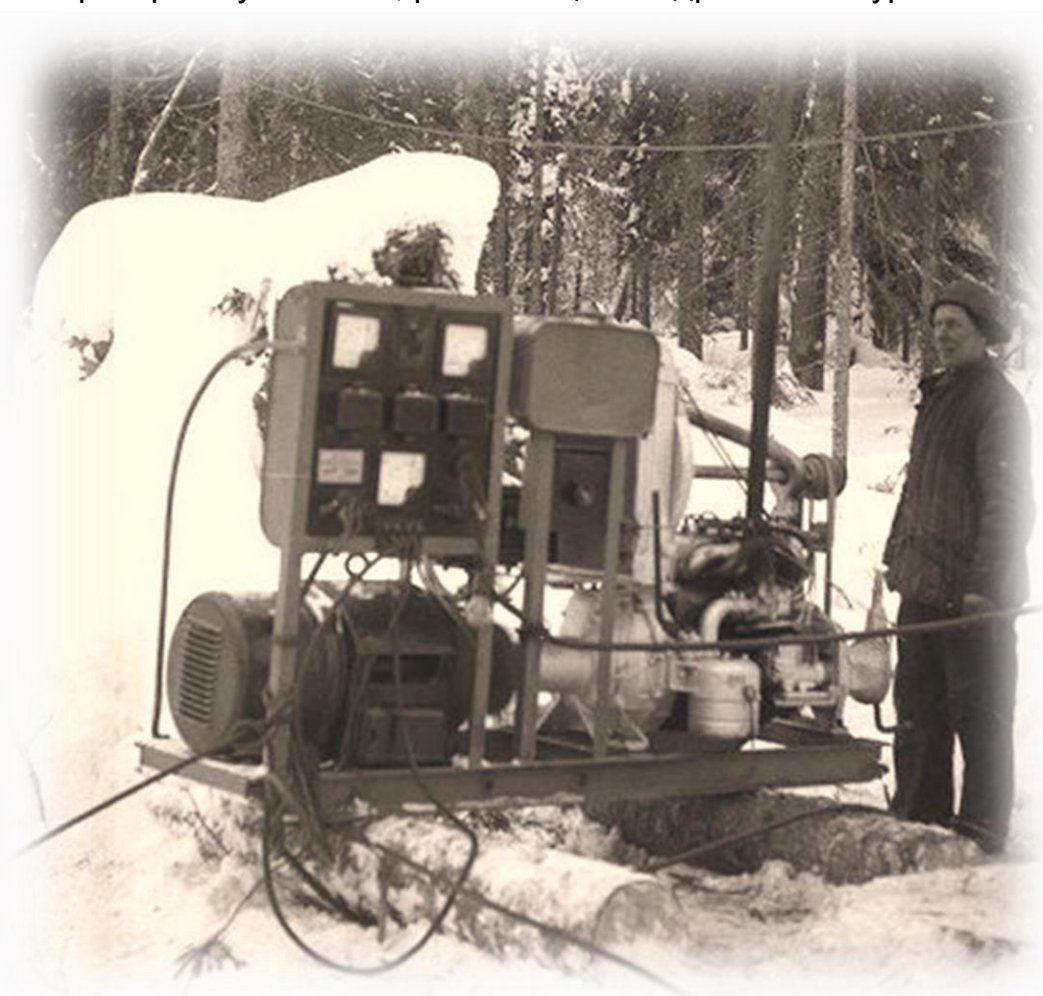
Передвижная электростанция ПЭС-12 бригады И.Ф. Козырева (Автор фото: Блейхман Е.А.)
