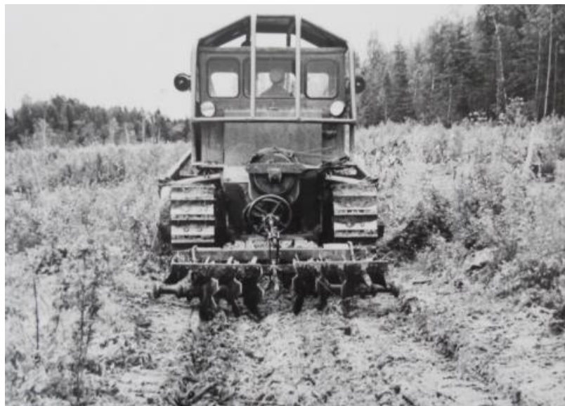
Рис. 2.16. Борона дисковая тяжелая БДТ-2,2 в агрегате с трактором С-100
