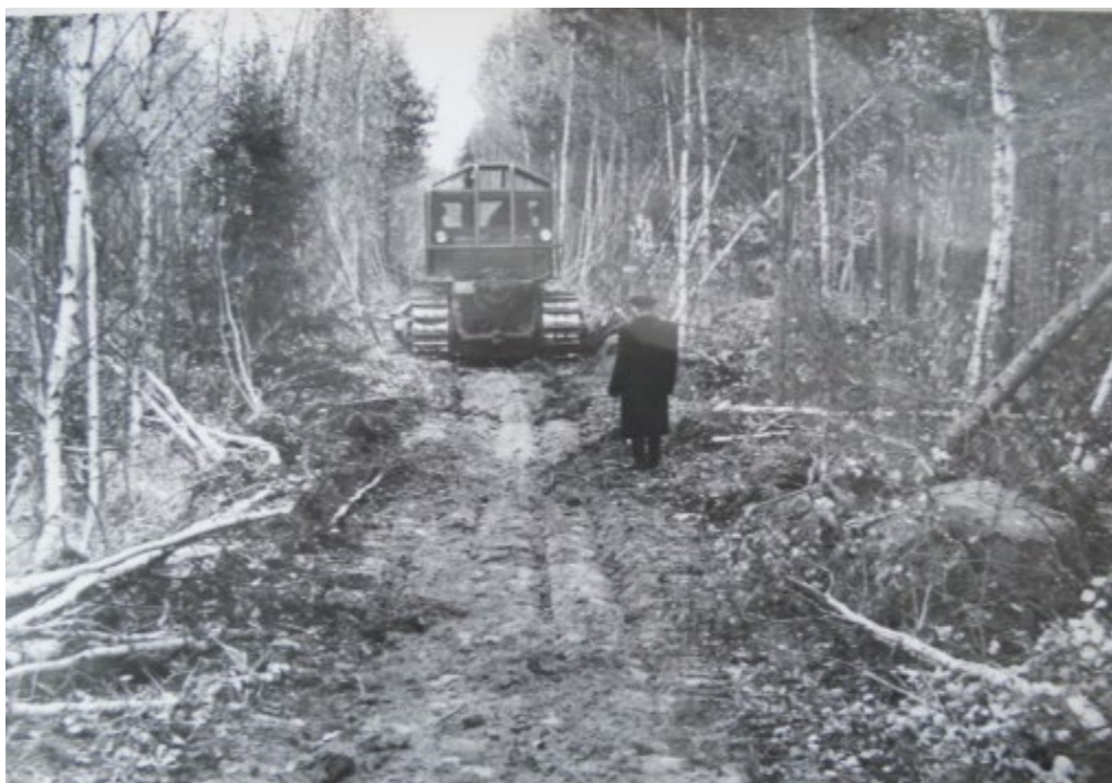
Рис. П1.2. Корчеватель-сбиратель Д-210В осуществляет вычесывание корней и корчевку мелких пней после прохода кустореза Д-174Б на объекте № 5 коридорной реконструкции (1958 г.)
